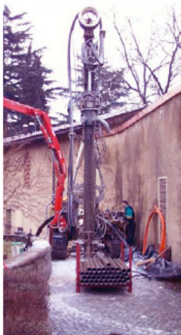
Esecuzione del foro di sondaggio per la messa di una sonda geotermica [5].
